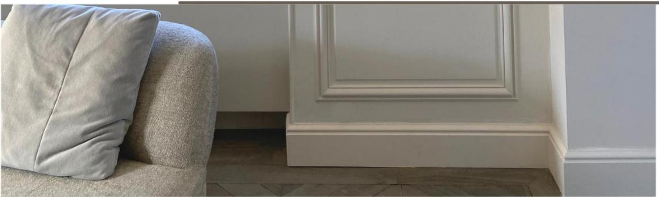
Les plinthes étant enduites de plâtre après leur pose, les joints en deviennent invisibles. Aucune délimitation ne peut être perçue, le résultat est propre, épuré.
